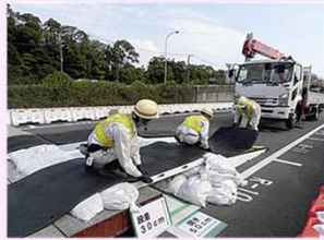
道路啓開訓練
